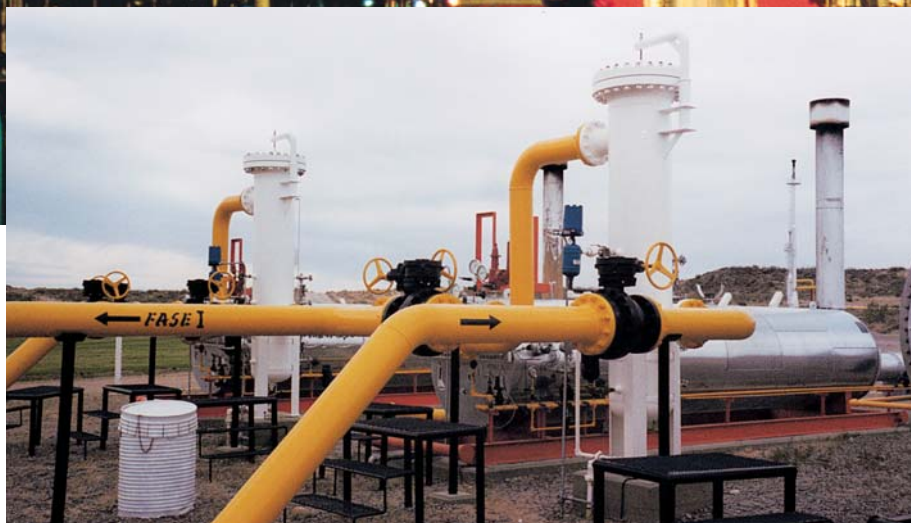
Система коалесцеров Сепрасол Жидкости/Жидкость защищает компрессор.
