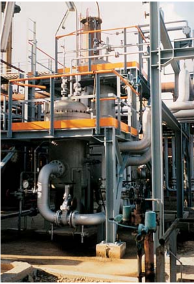
Вертикальная система коалесцеров Аквасеп Плюс Жидкость/Жидкость удаляет воду из керосина.
