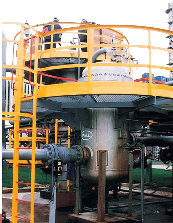
Вертикальная система коалесцеров Аквасеп Плюс Жидкость/Жидкость удаляет воду из дизеля.
