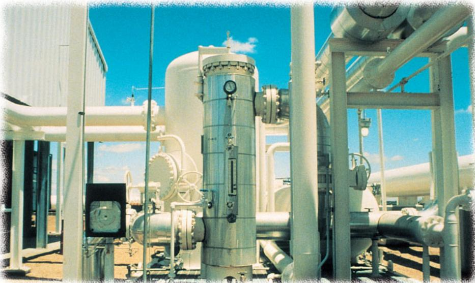
水素コンプレッサーの保護に“LGコアレッサー”が設置された例
