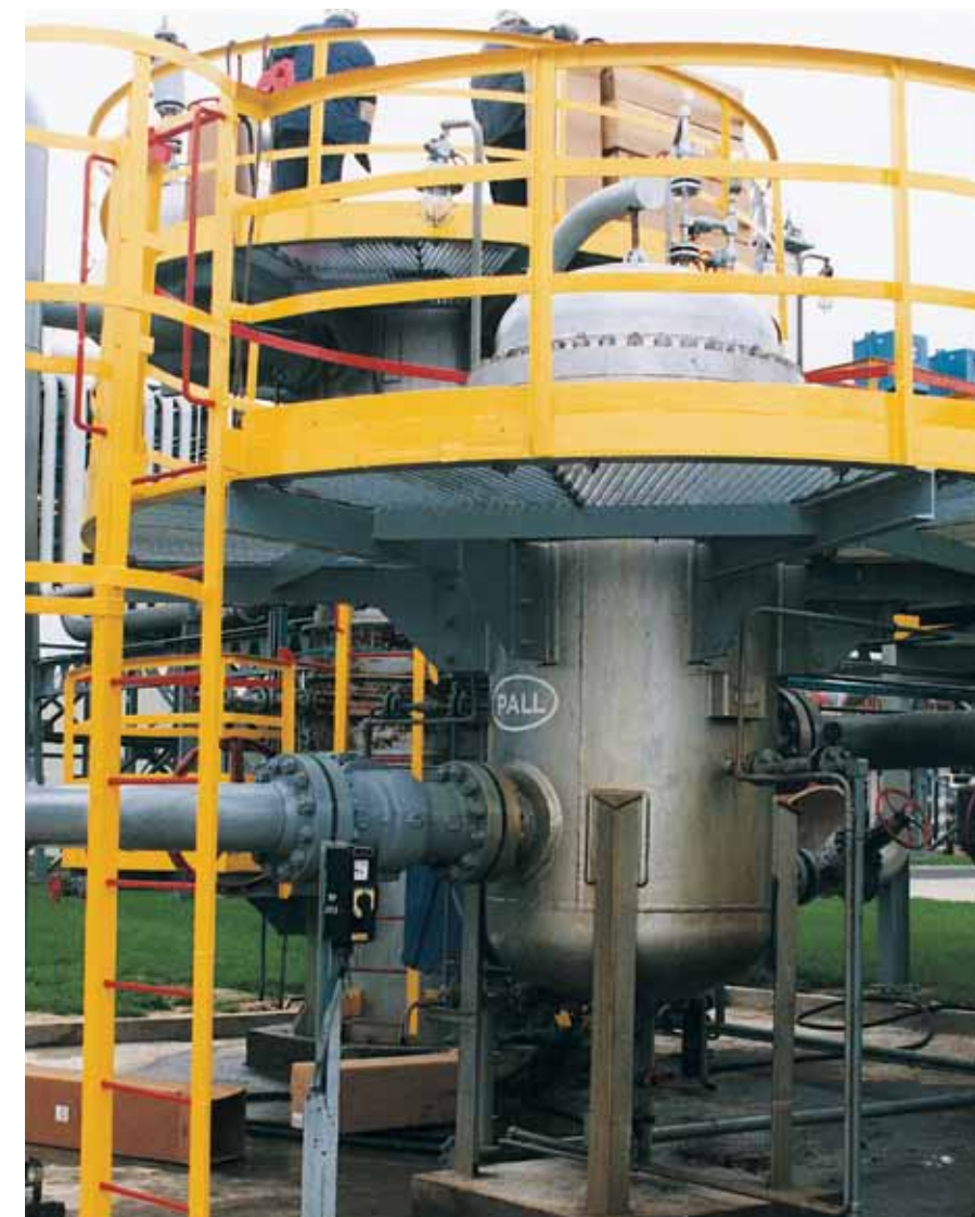
Коалесцеры Pall AquaSep Plus и PhaseSep – наиболее эффективная технология сепарации жидкостей, в т. ч. по сравнению с резервуарами-отстойниками, электростатическими осадителями, солевыми осушителями и коалесцерами с сетчатыми насадками.
