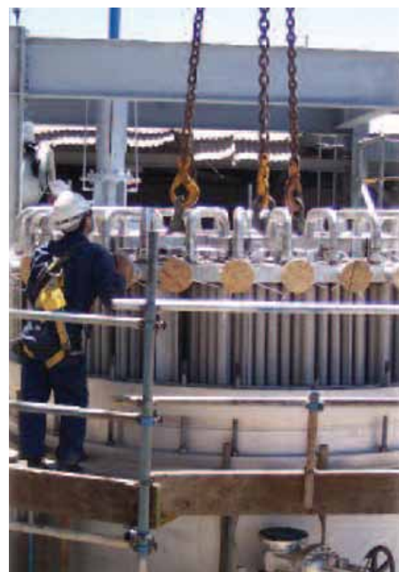
Установка трубной решетки в сборе с фильтроэлементами
