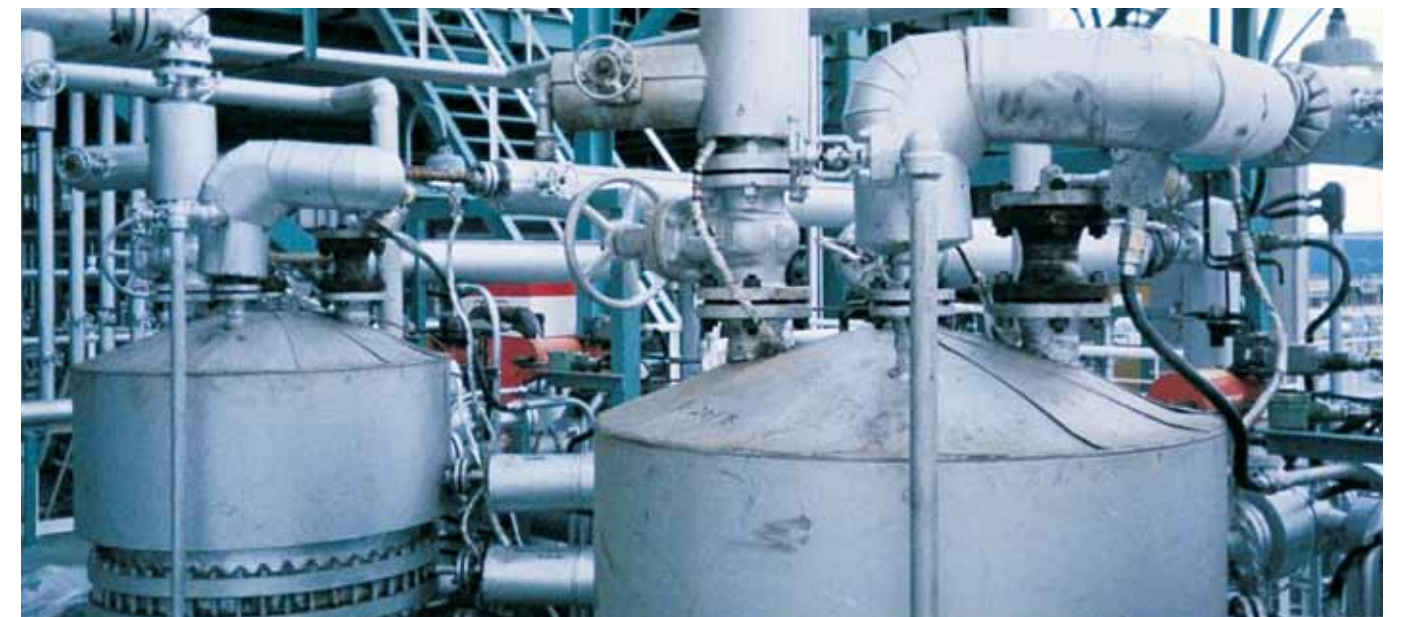
Фильтры Pall со сбросом осадка обратной продувкой газа используются для удаления микрочастиц катализатора из отходящего газа.
