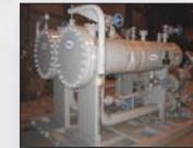
Sistema de membranas cerámicas usado para tratar aguas residuales de emulsiones de laminación en frío
