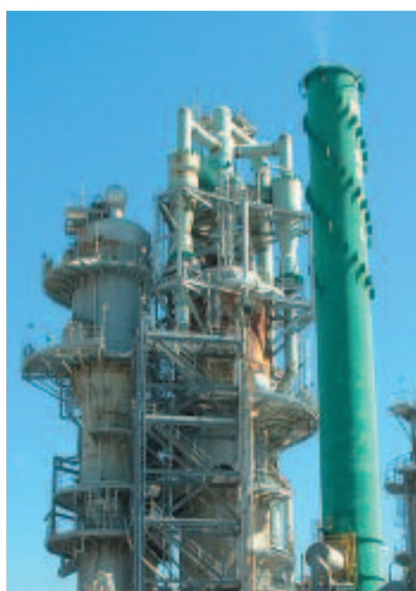
Fig 1: external cyclones BP Kwinana RCCU R2 regenerator
