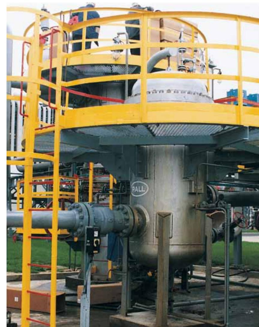
Коалесцеры Pall AquaSep Plus и PhaseSep – наиболее эффективная технология сепарации жидкостей, в т. ч. по сравнению с резервуарами-отстойниками, электростатическими осадителями, солевыми осушителями и коалесцерами с сетчатыми насадками.
