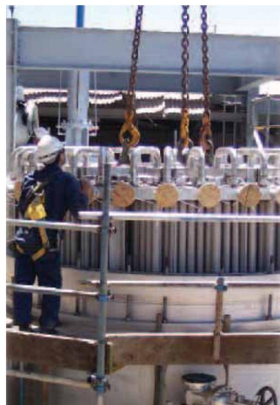
Установка трубной решетки в сборе с фильтроэлементами
