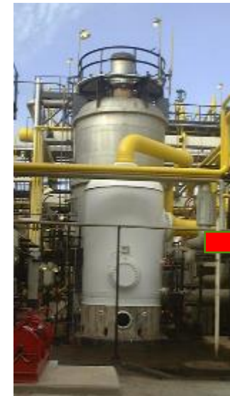
既設のセパレーター を取り外し
