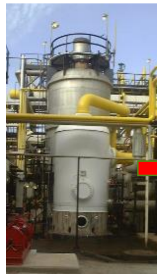
既設のセパレーター を取り外し
