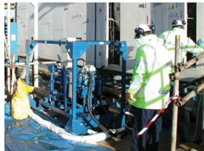
Serviços de flushing
