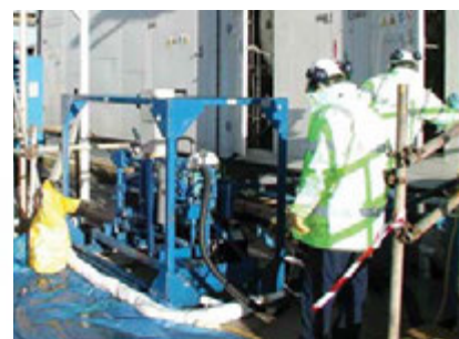
Serviços de flushing
